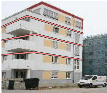
Die Ausbildung von Brandriegel ist ab einer Dämmstärke von mehr als 10 cm im Geschossbau Pflicht !
